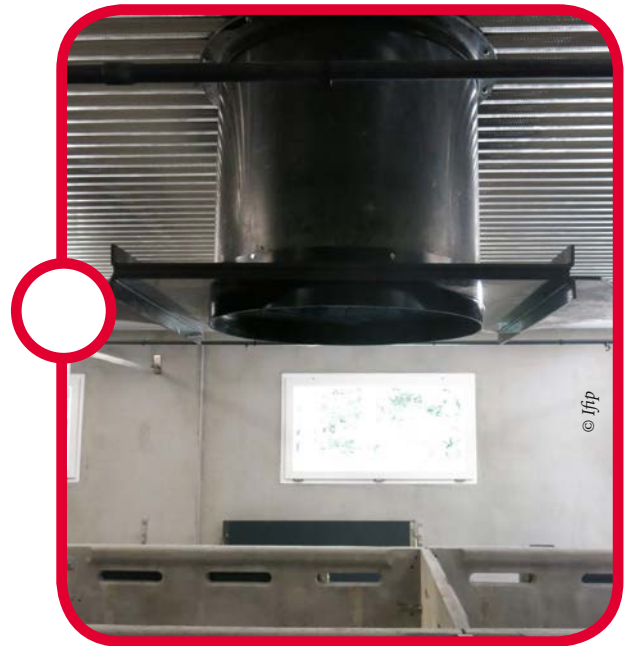
Pompage dans la masse
