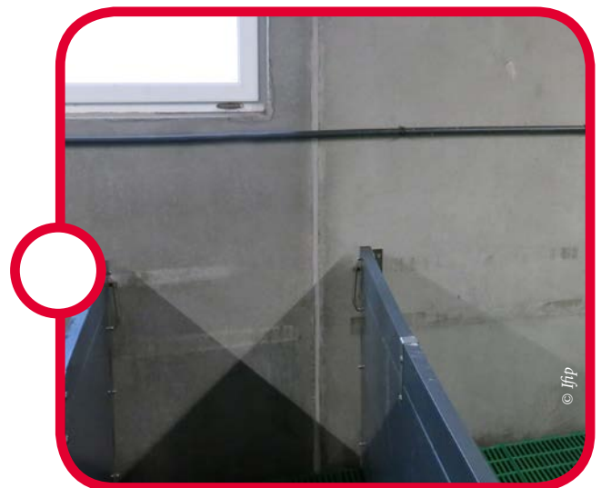
Pas de vanne de purge
