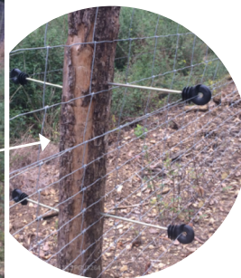
Clôture grillagée avec double électrification intérieure et extérieure
